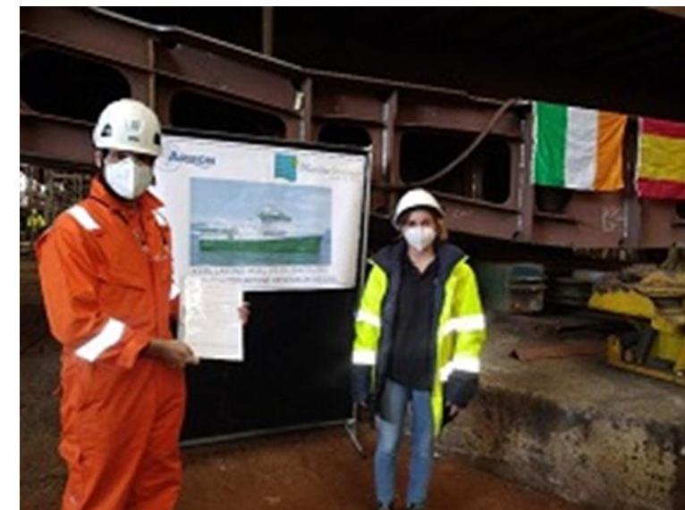
Keel lay November 2020
